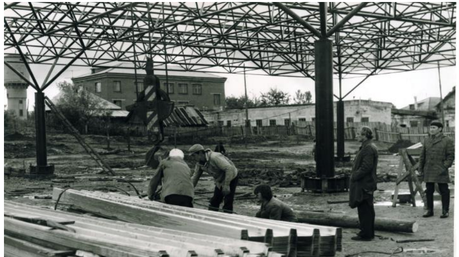
Строительство производственного корпуса Можгинского филиала завода «Элеконд», 1982 год.
